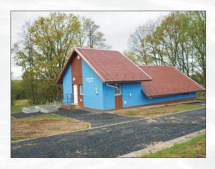
Čistírna odpadních vod Okrouhlá s návrhovou kapacitou 400 EO je součástí systému odvádění a čištění splaškových vod obce Okrouhlá u Chebu.
